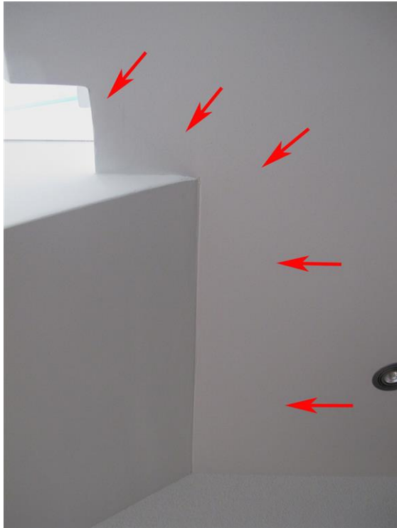
Foto 13: IMG_0004.jpg / Innen OG / Flur
