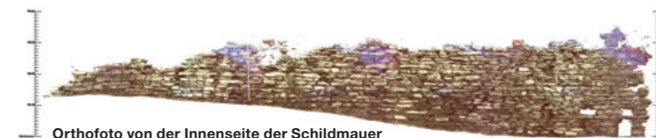
Orthofoto von der Innenseite der Schildmauer
