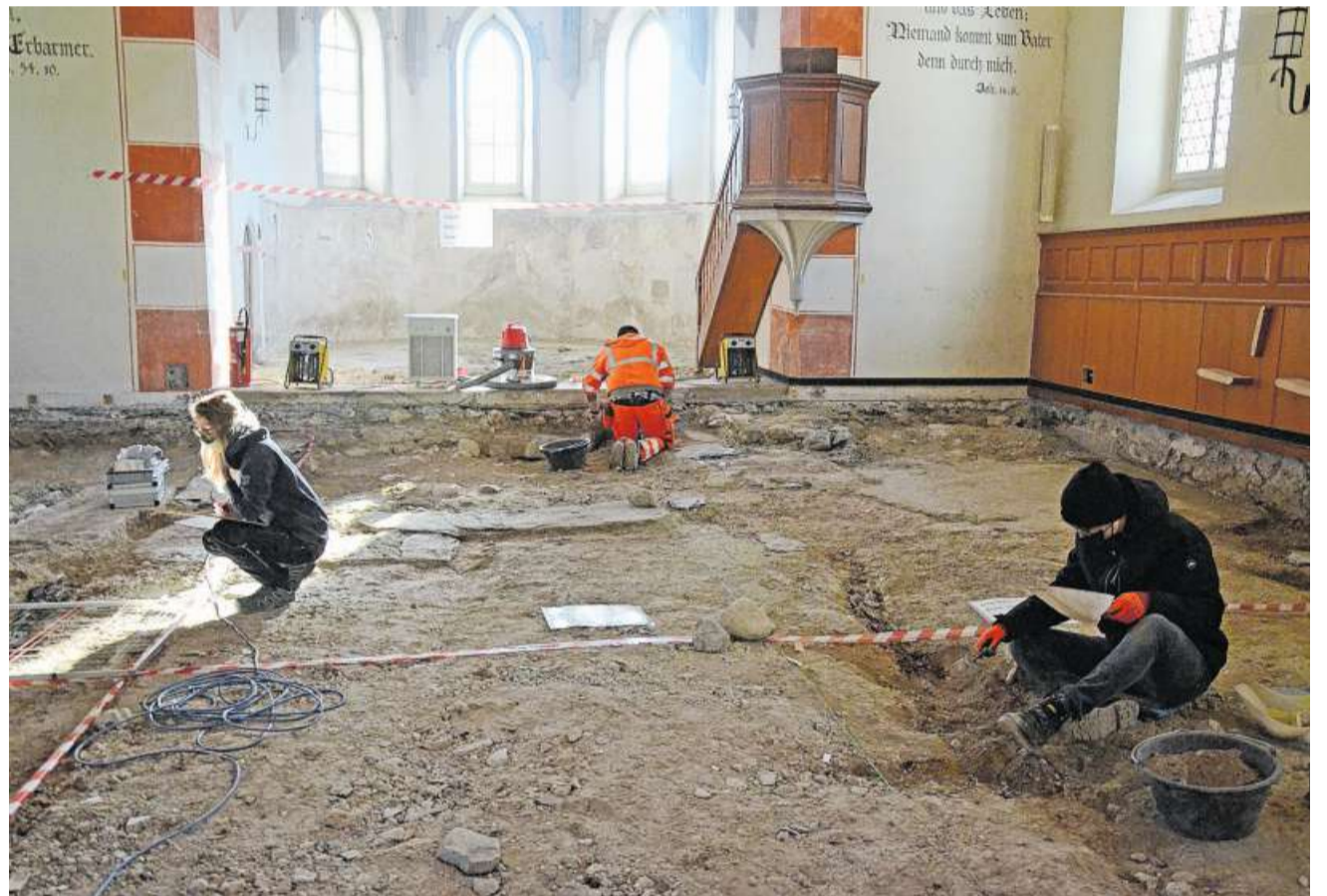
In der Kirche Sax kam jahrhundertealte Bausubstanz zum Vorschein.
